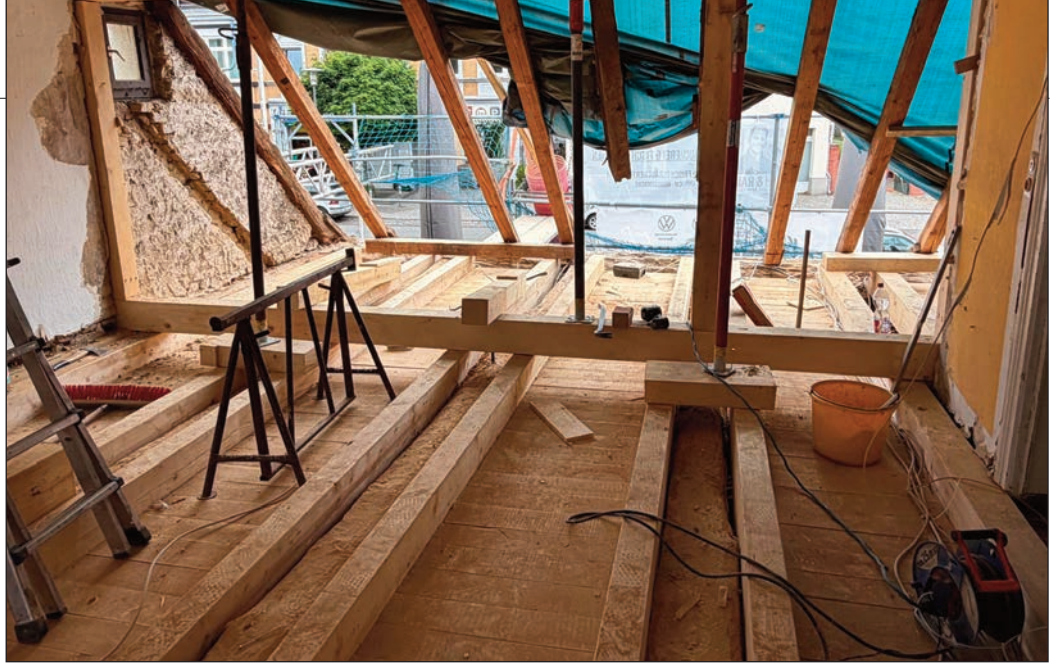
Mit der Fertigstellung des Dachstuhls wurde ein wichtiger Abschnitt der Sanierung abgeschlossen
