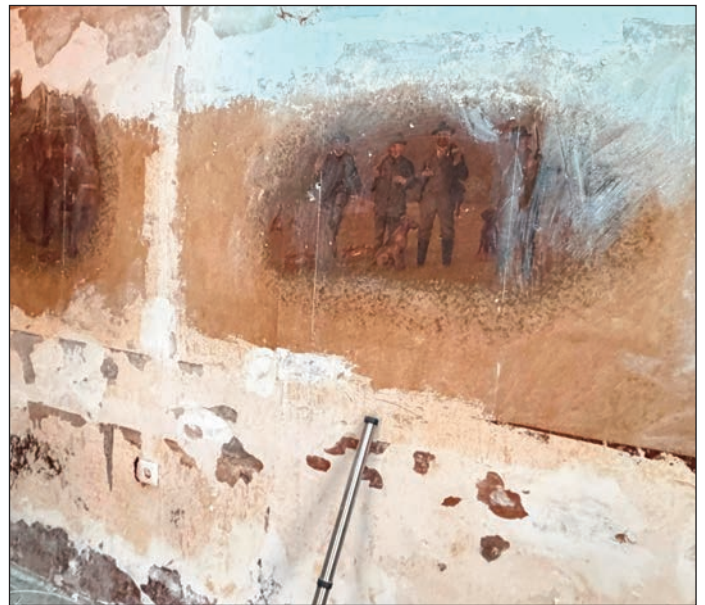
Während der Arbeiten kamen zudem überraschenderweise historische Wandmalereien zum Vorschein. Diese sollen erhalten bleiben.
